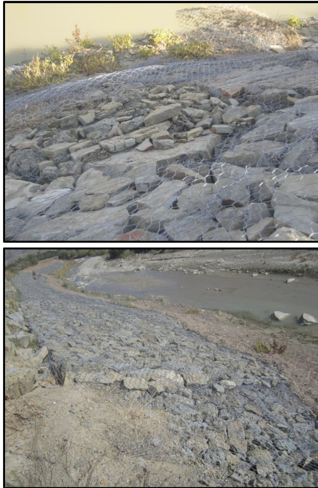
شکل ۴-۱- نمونه‌هایی از رخداد خرابی در توریسنگ‌ها
