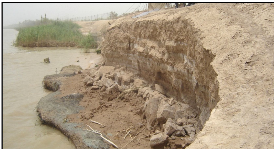
شکل ۲-۲- نمونه‌ای از رخداد پدیده ریزش کناره رودخانه
